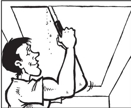
Corte la abertura en el techo con una sierra o con una navaja para tableros de yeso. Corte las viguetas del techo que estén dentro de la abertura y proporcione un soporte temporal. Enmarque la abertura con cabezales y viguetas, según requiera. **NOTA:** Para mantener la integridad estructural del techo, tal vez sea necesario utilizar cabezales, vigas y viguetas dobles.
