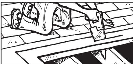
Corte la abertura en el techo, siguiendo las marcas, y quite el material de techado. Si cortará una viga intermedia, tal vez sea
